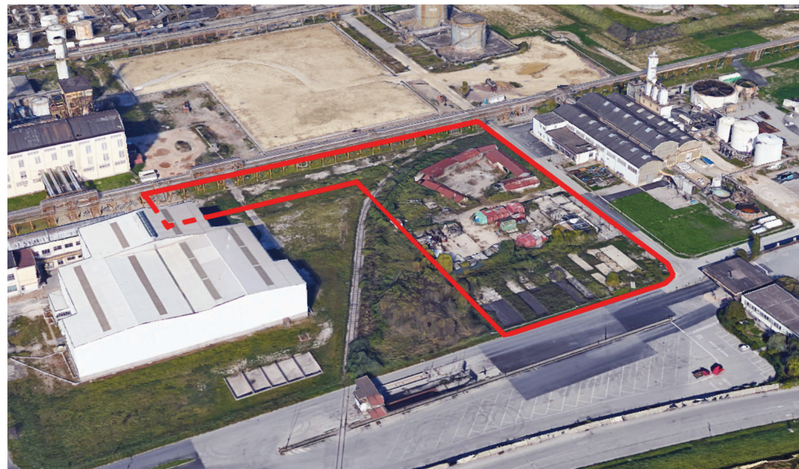
AREA 8.4 -PORZIONE CTE - ACQUA DEMI
